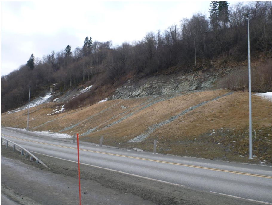
Foto 1 a,b: Plastrede/drenerte områder i skråningene langs rv 706
