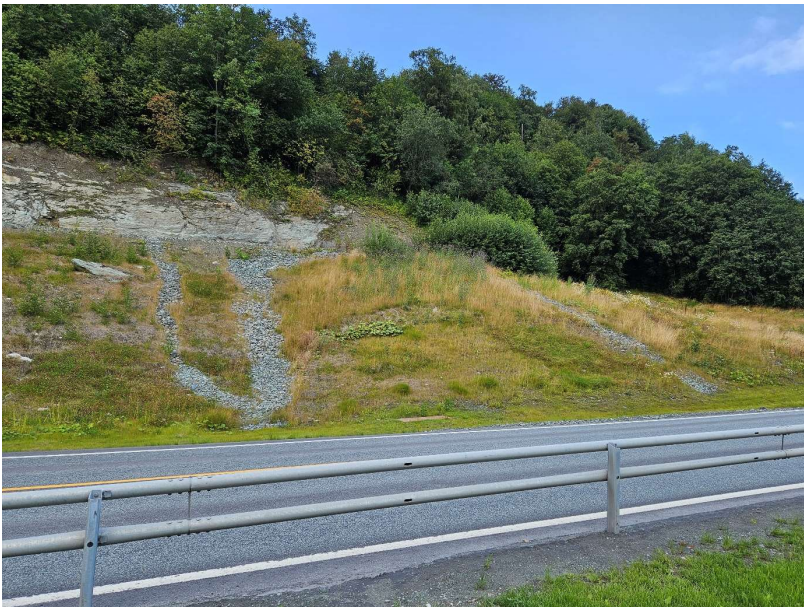
Figur 3-3: Bilde av revegetering i prosjektområdet til rv. 706 Nydalsbrua med tilknytninger , foto: Multiconsult, 2024
