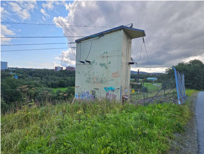
Figur 2-3: Bilde av Stavnetårnet, som står like ved gang- og sykkelvegen, foto: Multiconsult, 2024
