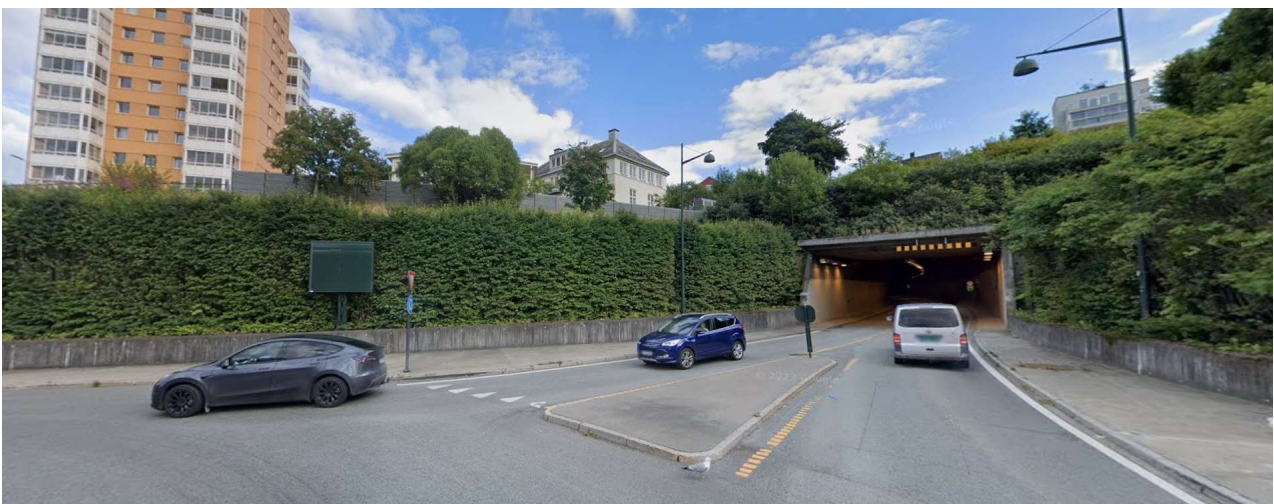
Figur 3-5: Skjermbilde av grønn mur ved rundkjøringen i Mellomila, over ti år senere når beplantningen har fått etablert seg. Hentet fra Google Maps, tatt august 2023
