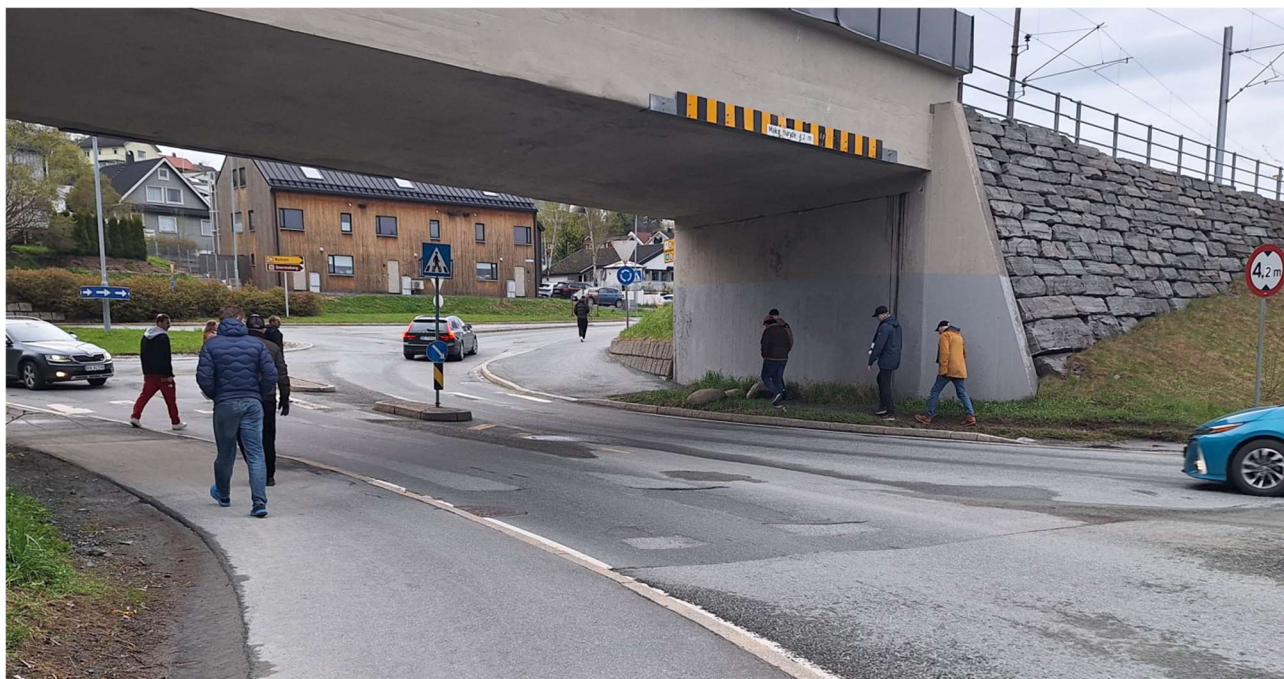
Figur 6-1. Dagens tilbud for gående og syklende er dårlig og vegstandarden er lav. I nordlige del av vegstrekningen ved Stavnerundkjøringa går gang- og sykkelveg under jernbanebru.
