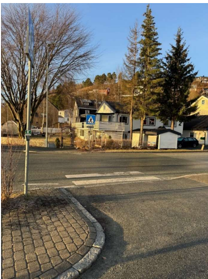
Figur 6–7 Eksisterende gangfelt i Breidablikveien hvor oppmerkingen er slitt bort. (Foto: Multiconsult)
