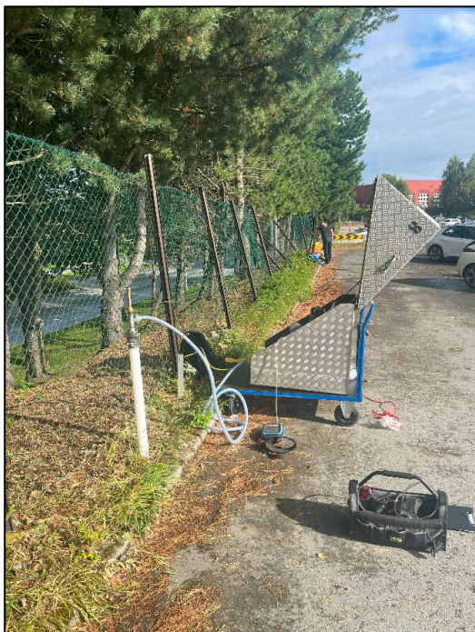
Figur 22 Bilde som viser oppsett for testpumping og måling av gassproduksjon i brønn S3-1.
