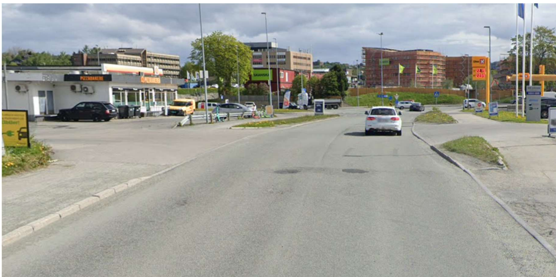
Figur 6: Avkjørsler ved bensinstasjonene og Rema lengst øst i Sluppenvegen
