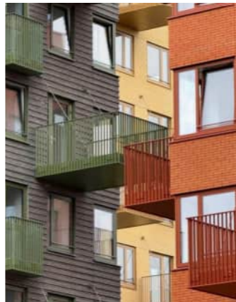
Fargerike balkonger med varierende dybde. Westerpark West, Amsterdam. (Kilde: MVRDV Architects)
