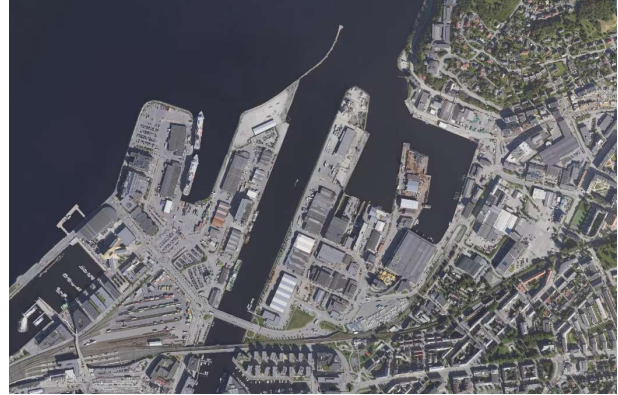
2022 (finn.no) Transittkaia er opparbeidet med definerte kanter og industri-/havnebebyggelse, Nidelvas utløp tangerer Ladehammen – øst for moloen.
