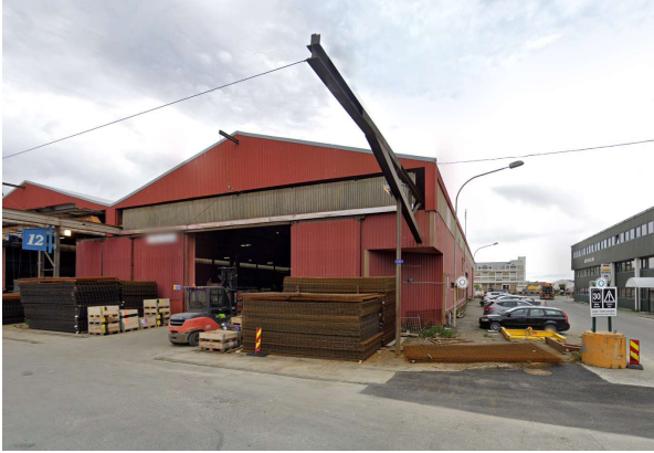
Transittgata 12, oppført på 60-tallet, med traverskranskiner.
