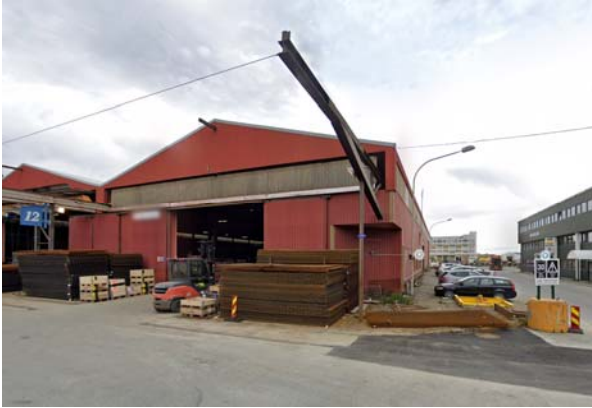
Transittgata 12, oppført på 60-tallet, med traverskranskiner.
