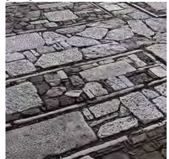
Sekundær belægning, genbrugt granit
