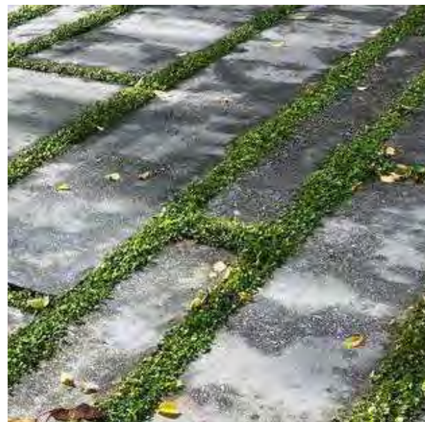
Sekundær belægning, genbrugt beton med
