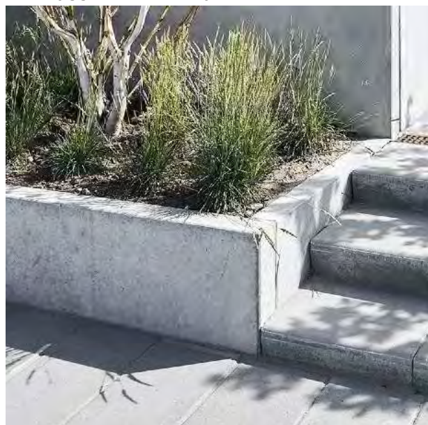
Støttemur ved hævet nærings kantzone
