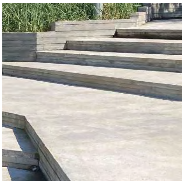
Insitu støbt nedtrapning, udføres med grov overflade
