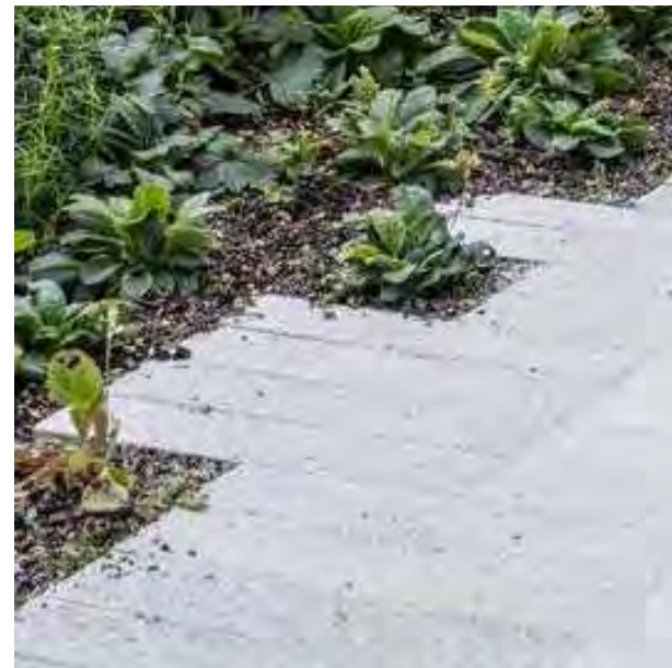
Primær belægning, beton med takket kant og ru overflade
