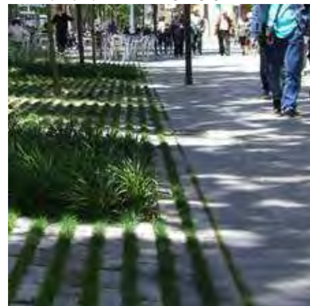
Eksempel på sekundær belægning, beton med grøn fuge
