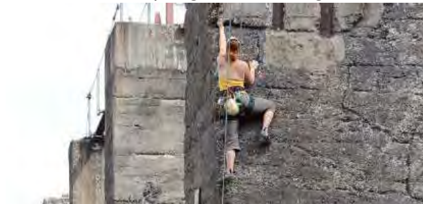
Insitu støbt nedtrapning, udføres med grov overflade
