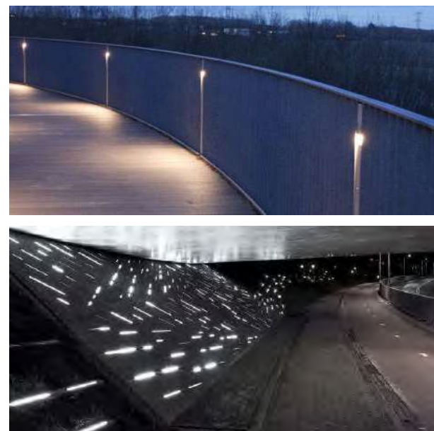
Effektbelysning integreret i værn og under bro
