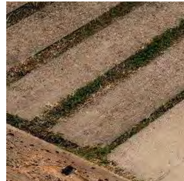
Belægning på plads i genbrug
