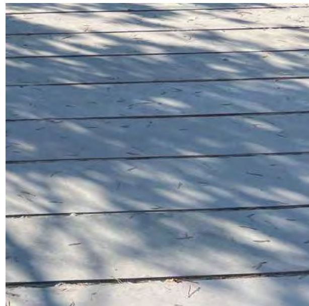
Primær belægning, beton lagt i bånd
