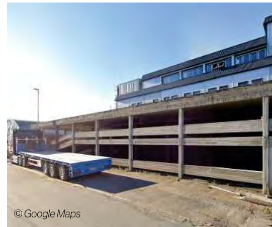
Eksisterende p-hus i beton
