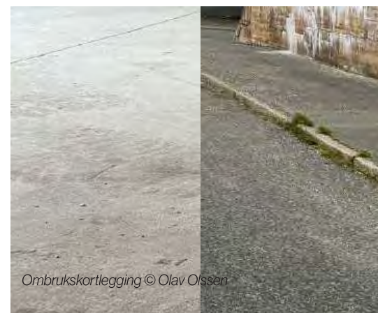
Eksistende fundamenter og asfalt
