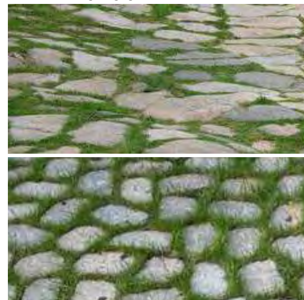
Sekundær belægning, beton med grøn fuge
