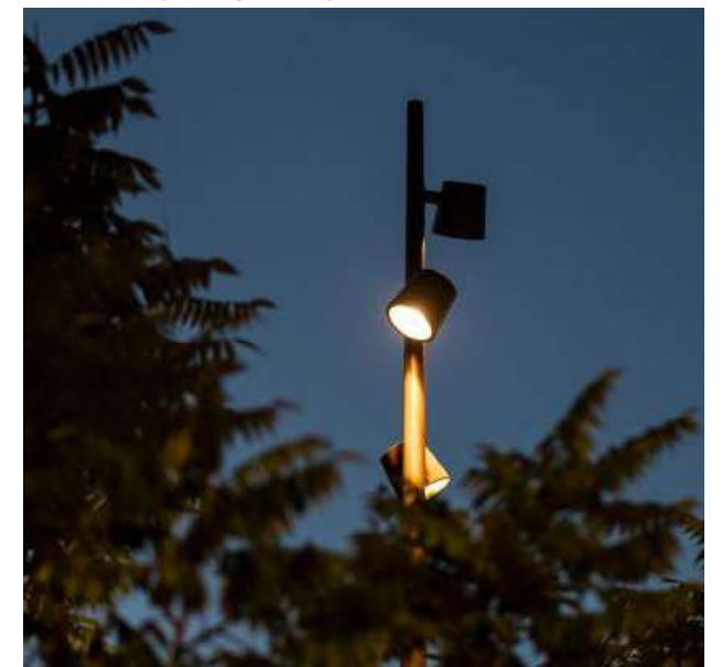
Mast belysning med spots
