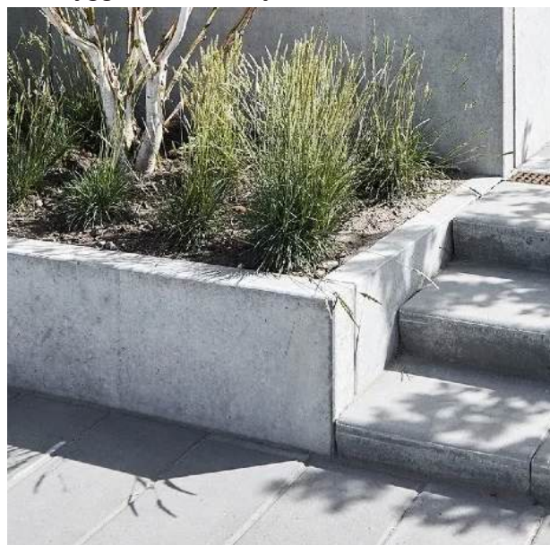
Støttemur ved hævet nærings kantzone
