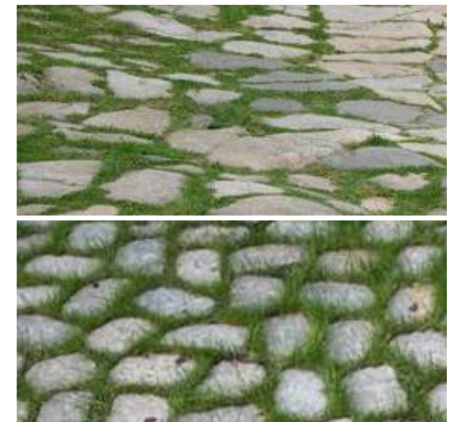
Eksempel på sekundær belægning, genanvendt granit med grøn fuge
