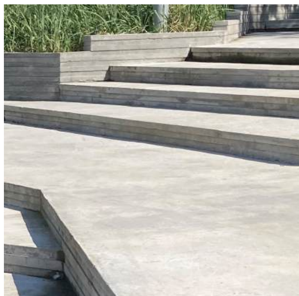
Insitu støbt nedtrapning, udføres med grov overflade
