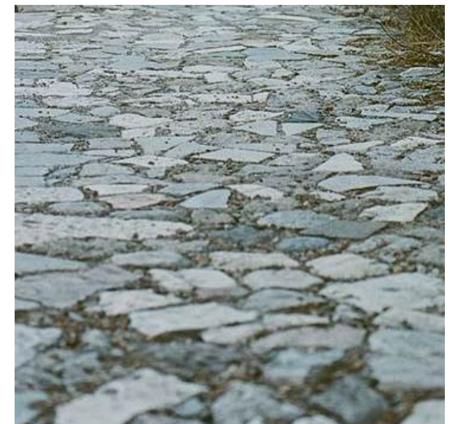
Sekundær belægning, granit
