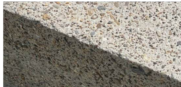
Støbt beton med riller eller tilslag ved nedtrapping
