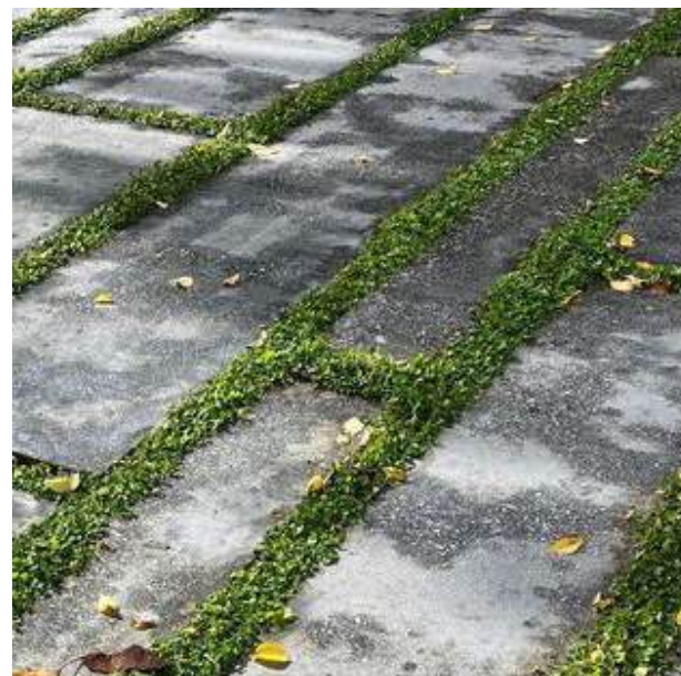
Sekundær belægning, genbrugt beton med
