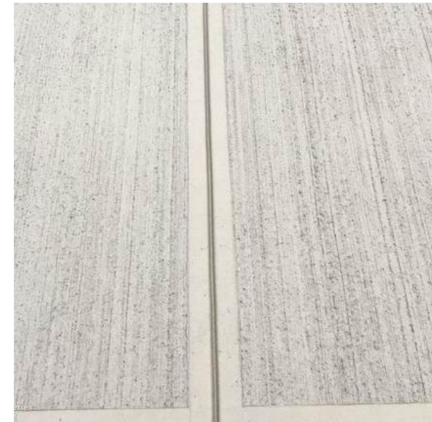
Primær belægning, beton med kostet overflade
