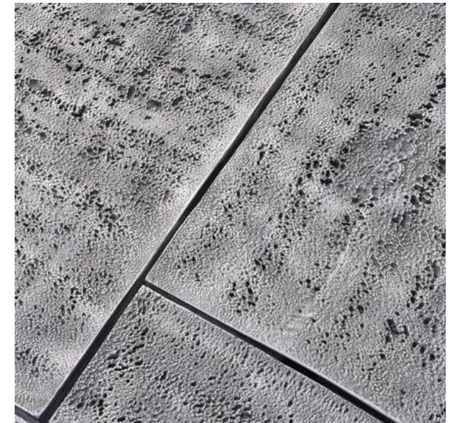
Primær belægning, beton med ru overflade muligt genbrug
