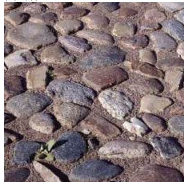
Sekundær belægning, granit
