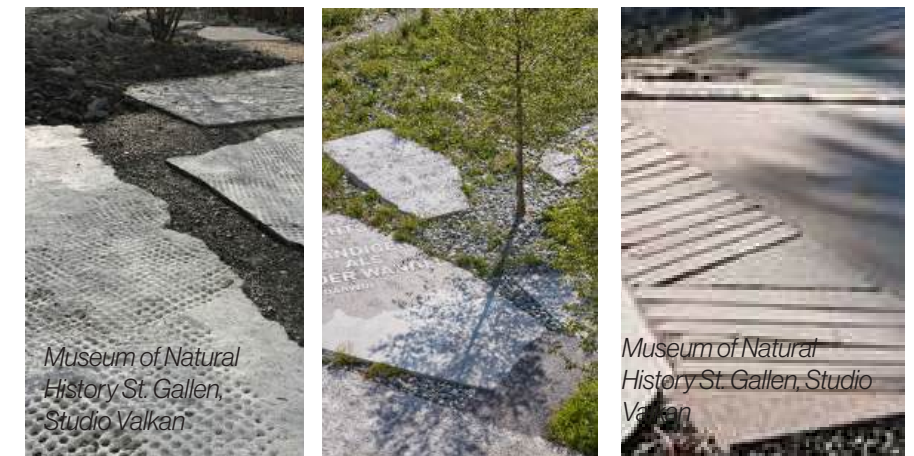
Eksempler på direkte genbrug af fundamenter som tilskårne elementer
