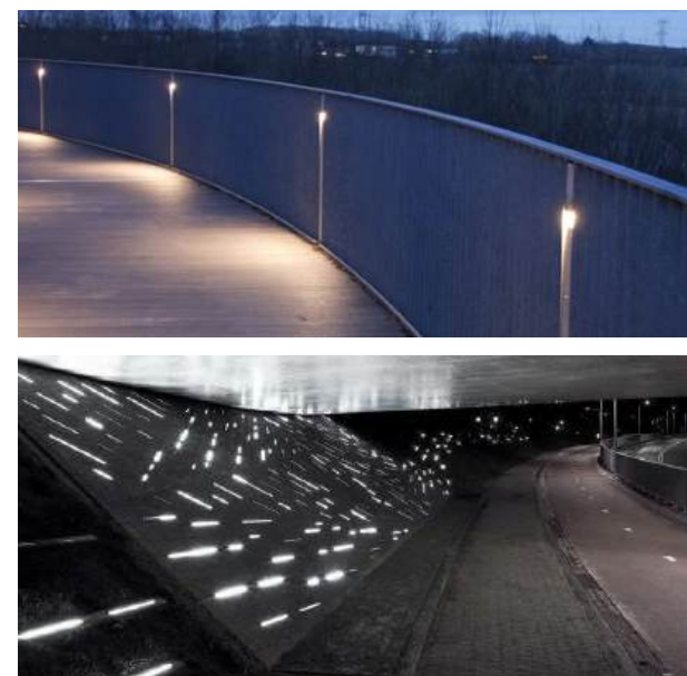
Effektbelysning integreret i værn og under bro
