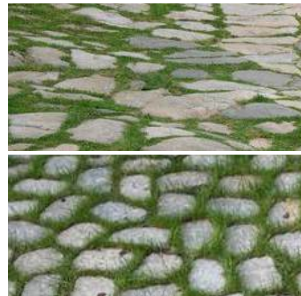
Sekundær belægning, beton med grøn fuge
