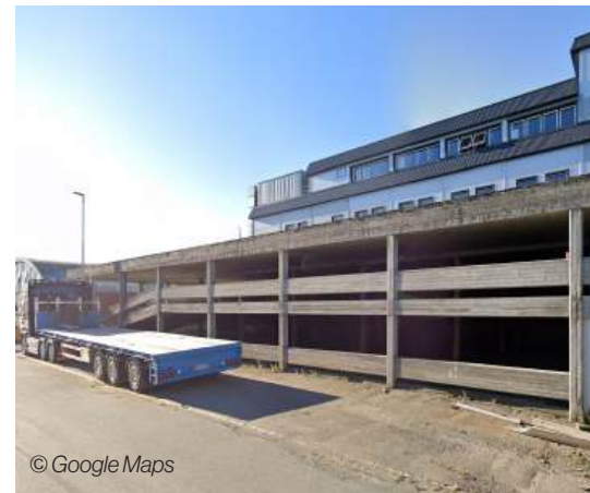
Eksisterende p-hus i beton
