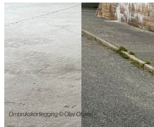
Eksistende fundamenter og asfalt
