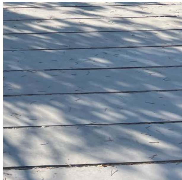
Primær belægning, beton lagt i bånd
