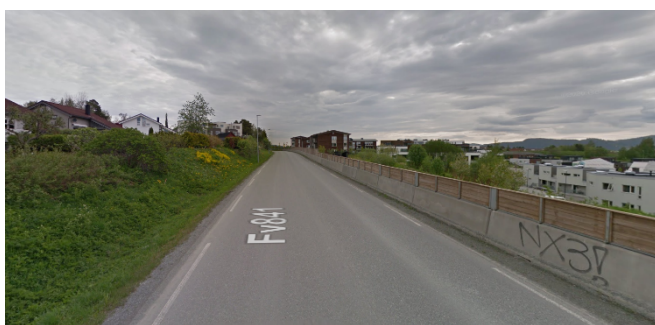
Bildet viser støyvoll på nordsiden av vegen hvor GS skal bygges til venstre, og støyskjerm foran nyere bebyggelse på sørsiden av vegen til høyre.
