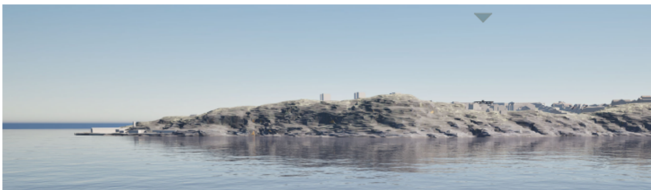
Fjernvirkning fra fjorden, uten trær. Planlagt bebyggelse er markert med pil
