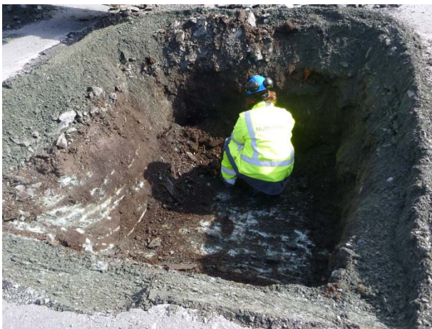
Figur 8 Bilde fra prøvesjakt HG5. Bærelag for asfalt og fyllmasser over fjell på 1,3meter.
