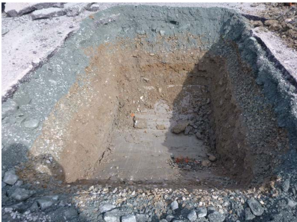
Figur 6 Bilde fra prøvesjakt HG3. Bærelag for asfalt, og fyllmasser, over original leire på 1,6 meter.
