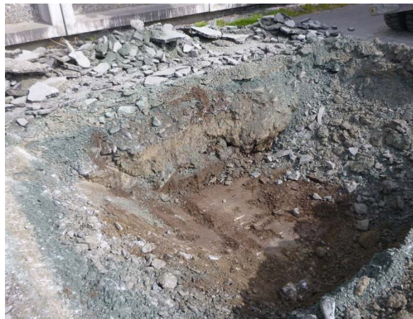
Figur 7 Bilde fra prøvesjakt HG4. Bærelag for asfalt og fyllmasser, over original leire på 1,1 meter.
