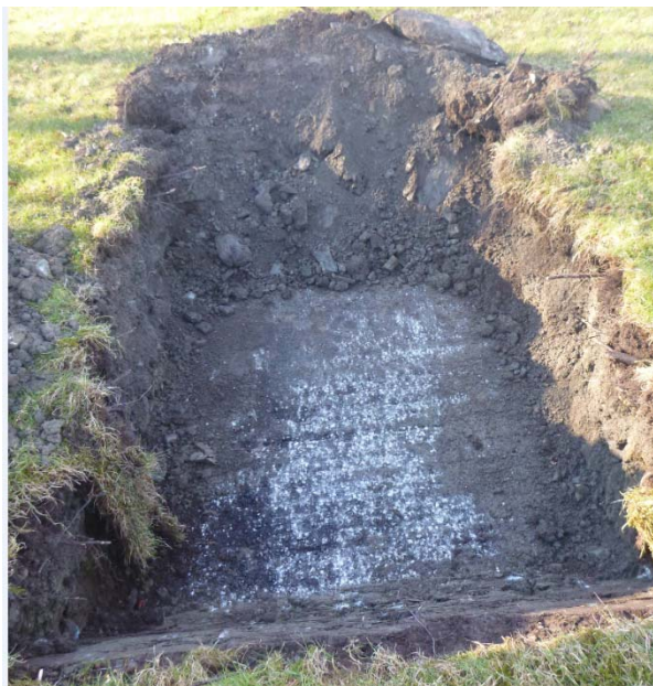
Figur 9 Bilde av prøvesjakt HG 1. Sjakta ble avsluttet i det som trolig er taket på en nedgravd tysk bunker fra 2. verdenskrig.
