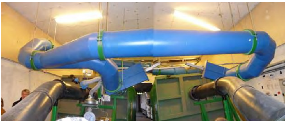
Figur 7 Avfallssugsentral uten komprimering (Nydalén i Oslo, foto: Aage Heie).
