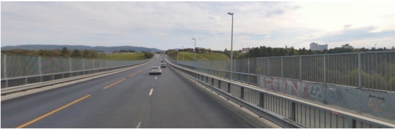
Typisk vegmiljø over Bjørndalsbrua: adskilt gang- og sykkelvei
