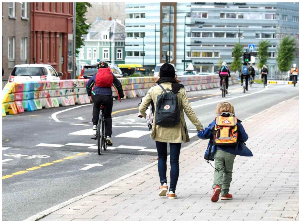
Figur 5 Nytt opphøyd gangfelt ved Nedre Møllenberg gate
