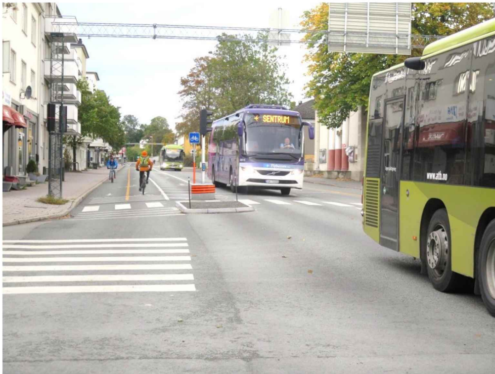
Figur 10 Ved Anders Buens gate krysser sykkelvegen i utvidet gangfelt
