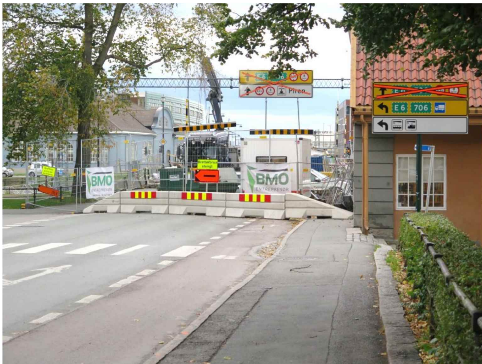
Figur 15 Brattørbrua stengt for all trafikk juli – september
