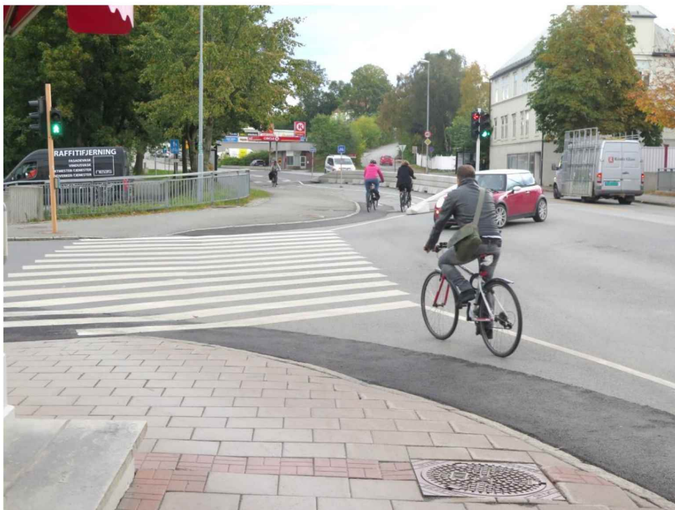
Figur 13 Utvidet gangfelt uten egne sykkel-signaler i kryss med Thomas von Westens gate
