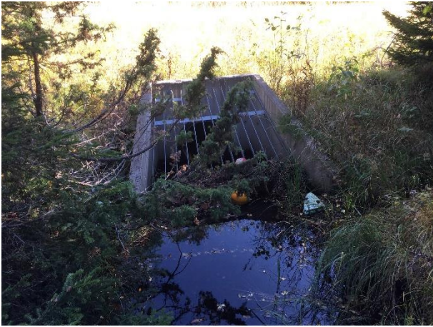
Figur 2: Inntak av vann fra myr ved rekrutthoppanlegget
