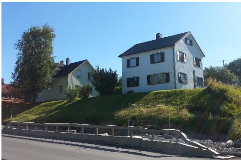
Fig. 9 Eneboliger langs Heimdalsvegen sør for Heimdal sentrum
