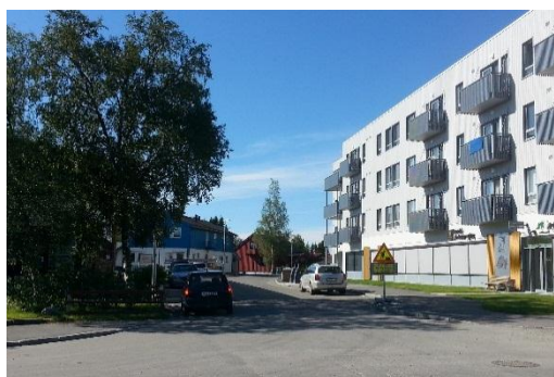
Fig. 24 Boligblokker i 4 etasjer i Kirkeringen
