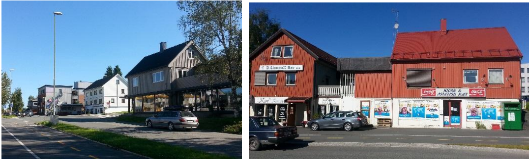
Fig.6 og7. Boliger med næring i 1 etasje langs Heimdalsvegen. Heimdalsvegen er tydelig markert gate.
