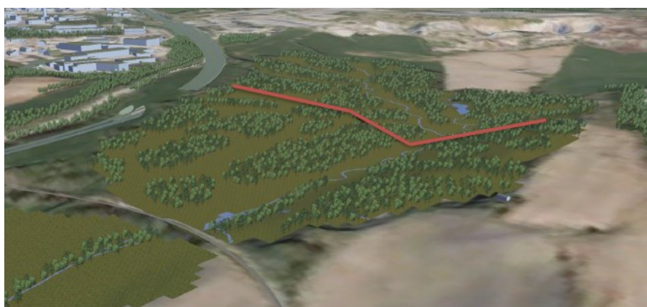
3D-bilder av ferdig planert terreng etter avslutning av tiltaket. Rød strek viserskille mellom fase 2 og 3, mens Dovrebanen nede til venstre er skille mellom fase 1 og 2.
