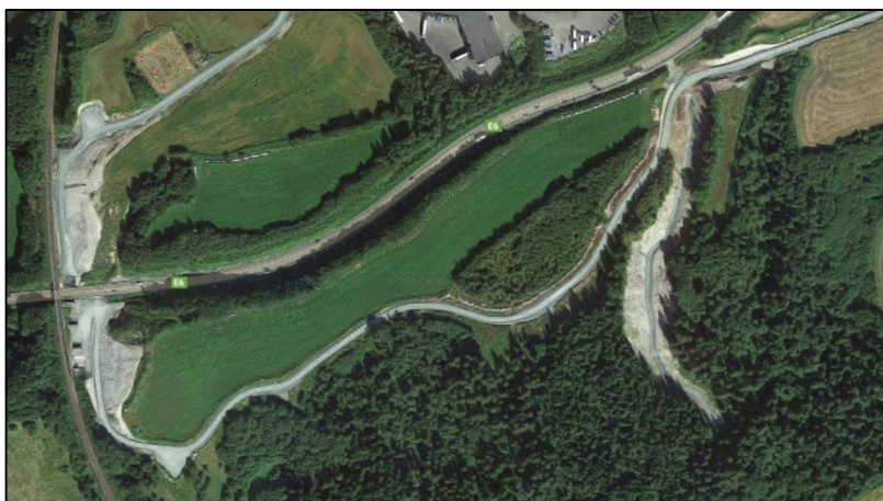
Figur 3 Eksisterende anleggsveg som kan benyttes som internveg i felt 2 og 3
