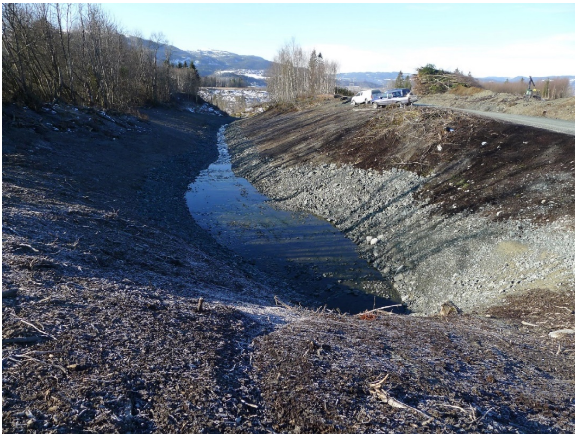
Figur 7. Dagens forbygde bekkeløp fra Hegstadmoen og inn i tiltaksområdet. Det framtidige hovedbekkeløpet bør være noe dypere og generelt bør bekkene ha mer svinger enn dette bildet viser. I tillegg bør sideterrenget gjøres mer ujamnt i lengderetningen langs bekkefaret.
