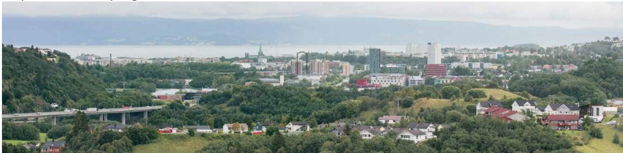
Fjernvirkning sett fra Okstadvegen. Omriss av boligbygget sees omtrent midt i bildet.
