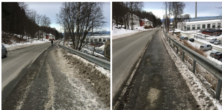
Tilstand på fortau på den oransje strekningen, viser at den er brukbar også på vinterstid.
