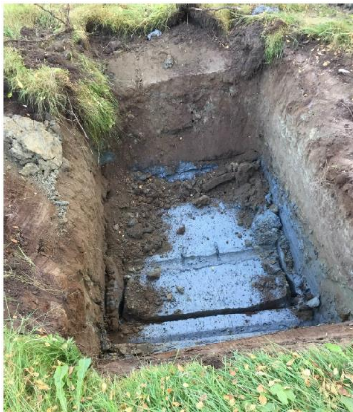
Figur 3: Bilde fra prøvegraving i Peder Morsets veg 1. Bløt leire under silt og torv påvist i dybde 1,8 m [12]
