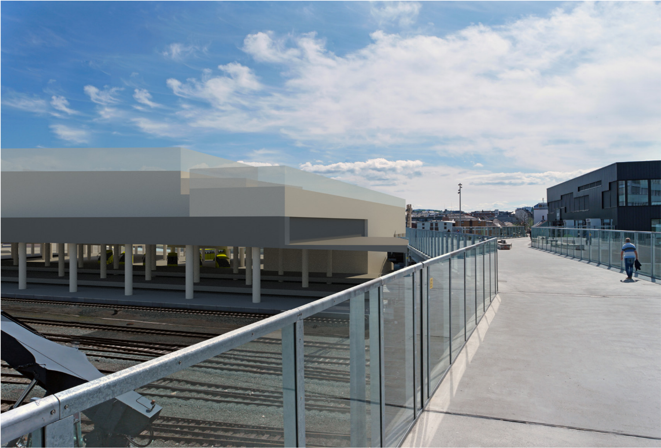
Plass C: Fra Sjøgangen
