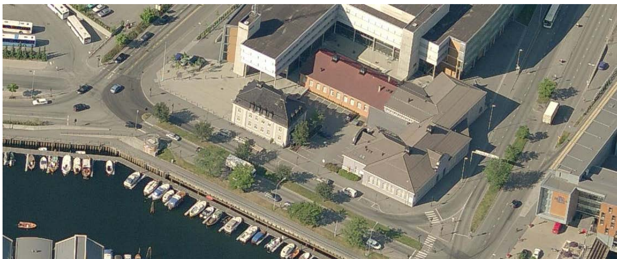
Figur 16 De to bygningene fra gamle Trondheim Slaktehus som gjenstår. Kilde: Gule sider.
