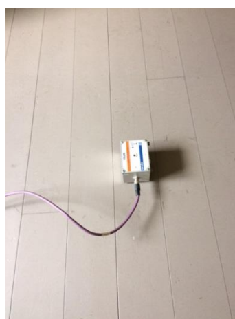
Sensor montert på gulv.
