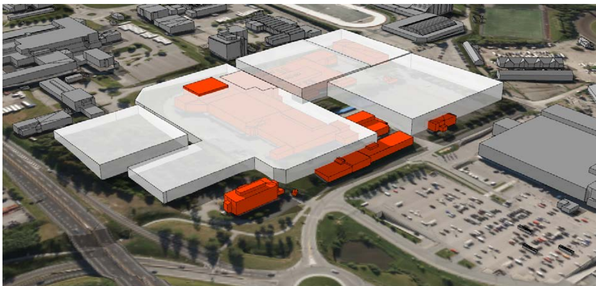
Figur 10 På illustrasjonen er eksisterende og foreslått bebyggelse sammenstilt. Foreslåtte byggegrenser og byggehøyder er vist som hvite, gjennomsiktige volumer. Eksisterende bebyggelse innenfor planområdet er vist med rødt. IKEA til høyre på illustrasjonen.
