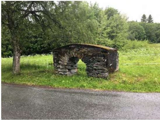
Deler av fjøsets grunnmur/inngang til fraukjeller sees fortsatt i svingen
