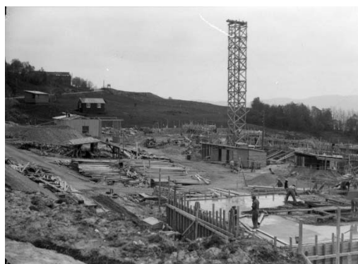
Oppstart bygging av Ringvål sanatorium 1933, låven på gården sees til venstre på haugen
