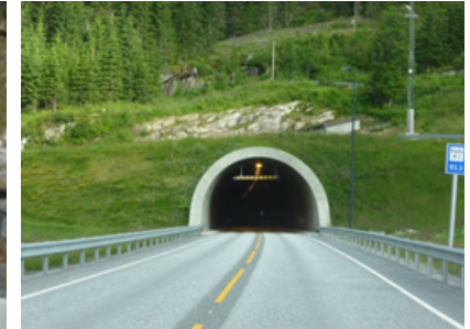
Portalområder som ligger lettere i landskapet kan utføres med portalbrem med helning 1:2/1:1,5 slik at terreng føres ned fra overkant forskjæring langs portalene.
