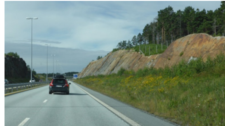
Fjellveggene langs en vei er viktig del av sideterrenget. Skråninger legges med helning for å minimere rekkverksbehov. Fjellskjæringer skal tilpasses bergets kvalitet. Fjellets helning vil variere etter de gitte forhold. Bildet er tatt på E18 mellom Grimstad og Kristiansand. Foto: Henrik Undeland.
