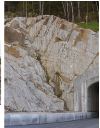
Portalområder som ligger lettere i landskapet kan utføres med portalbrem med helning 1:2/1:1,5 slik at terreng føres ned fra overkant forskjæring langs portalene.
