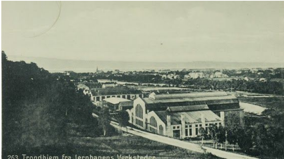
Marienborg etter at første byggetrinn var reist omkring 1920. Copyright NTNU/UB
