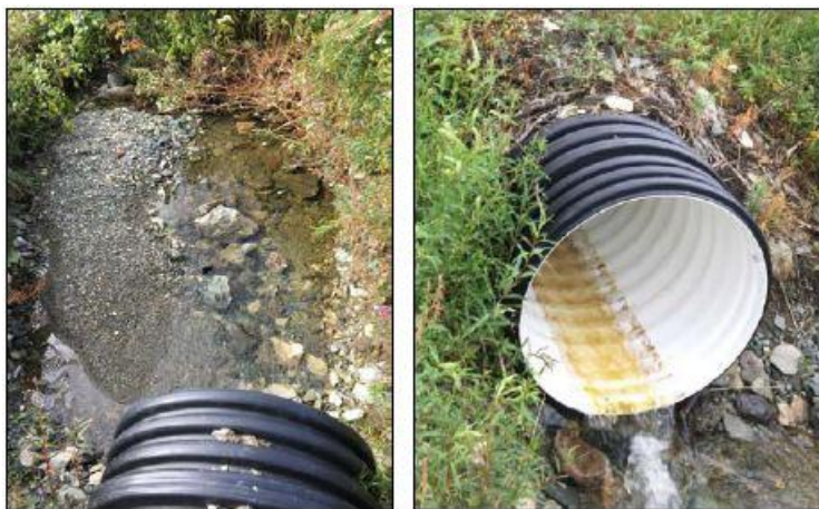
Skirna kulvert – utløp (kilde SVV)
