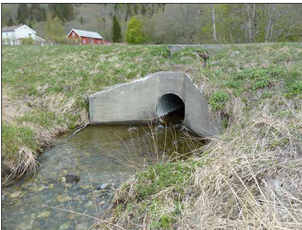
Figur 6: Utløpet til eksisterende kulvert i Skirna.
