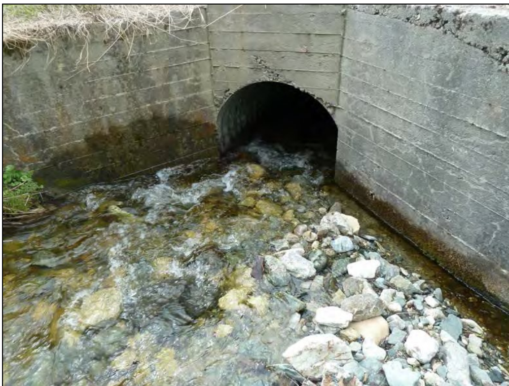
Figur 5: Innløpet til eksisterende kulvert i Skirna.
