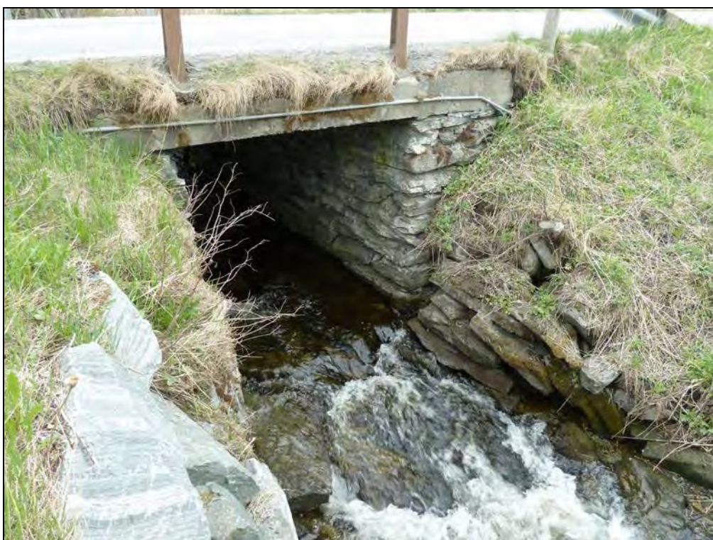
Figur 4: Utløpet til eksisterende kulvert i Kvisetbekken.
