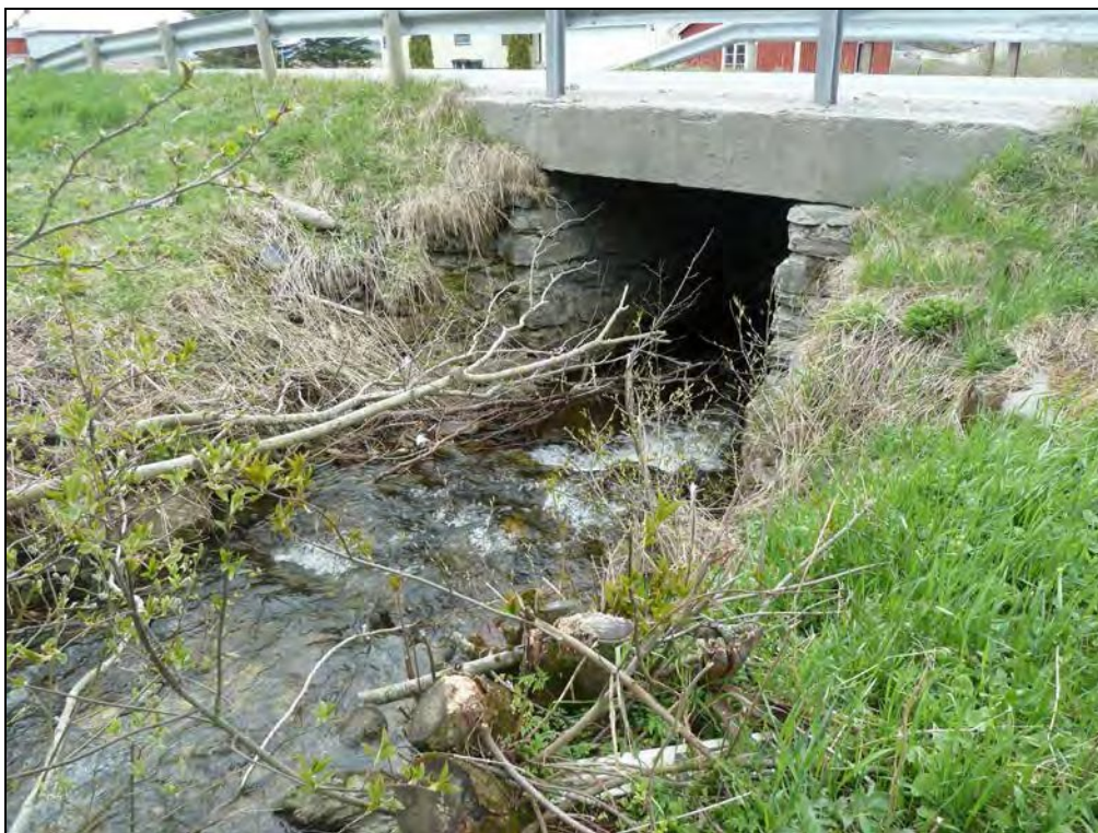
Figur 3: Innløpet til eksisterende kulvert i Kvisetbekken.
