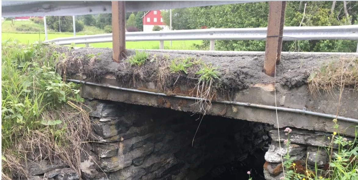
Montert brurekkverk-0,82 m høy, stolpeavstand 1,77. Brulengde 2,0 m. Kulverthøyde 1,8 m
