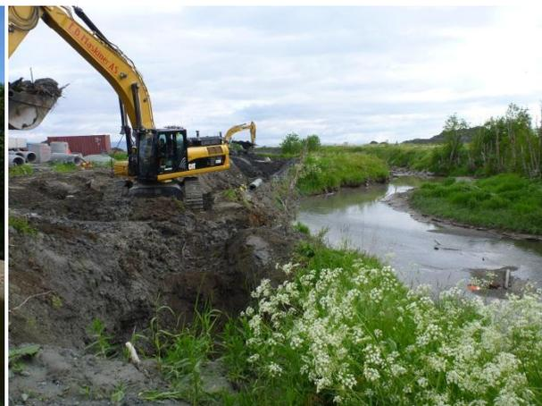
Figur 3 Vikelva før gravearbeider i elva. Bildet viser utgraving for trasé 8 (overløpsledning).
