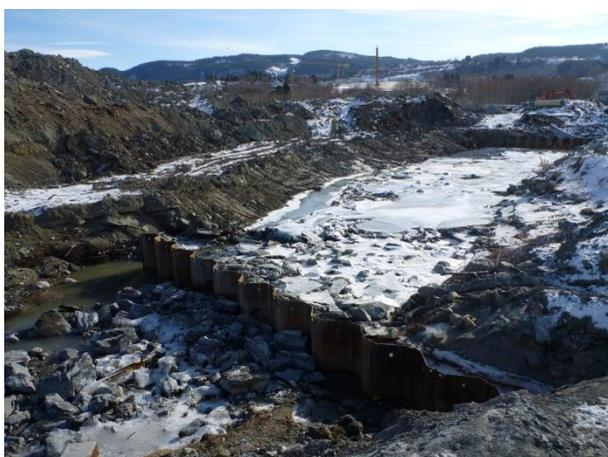
Figur 4 Tersklene ble bygget ved tørr gravegrop. Elva går i rør på venstre side.
