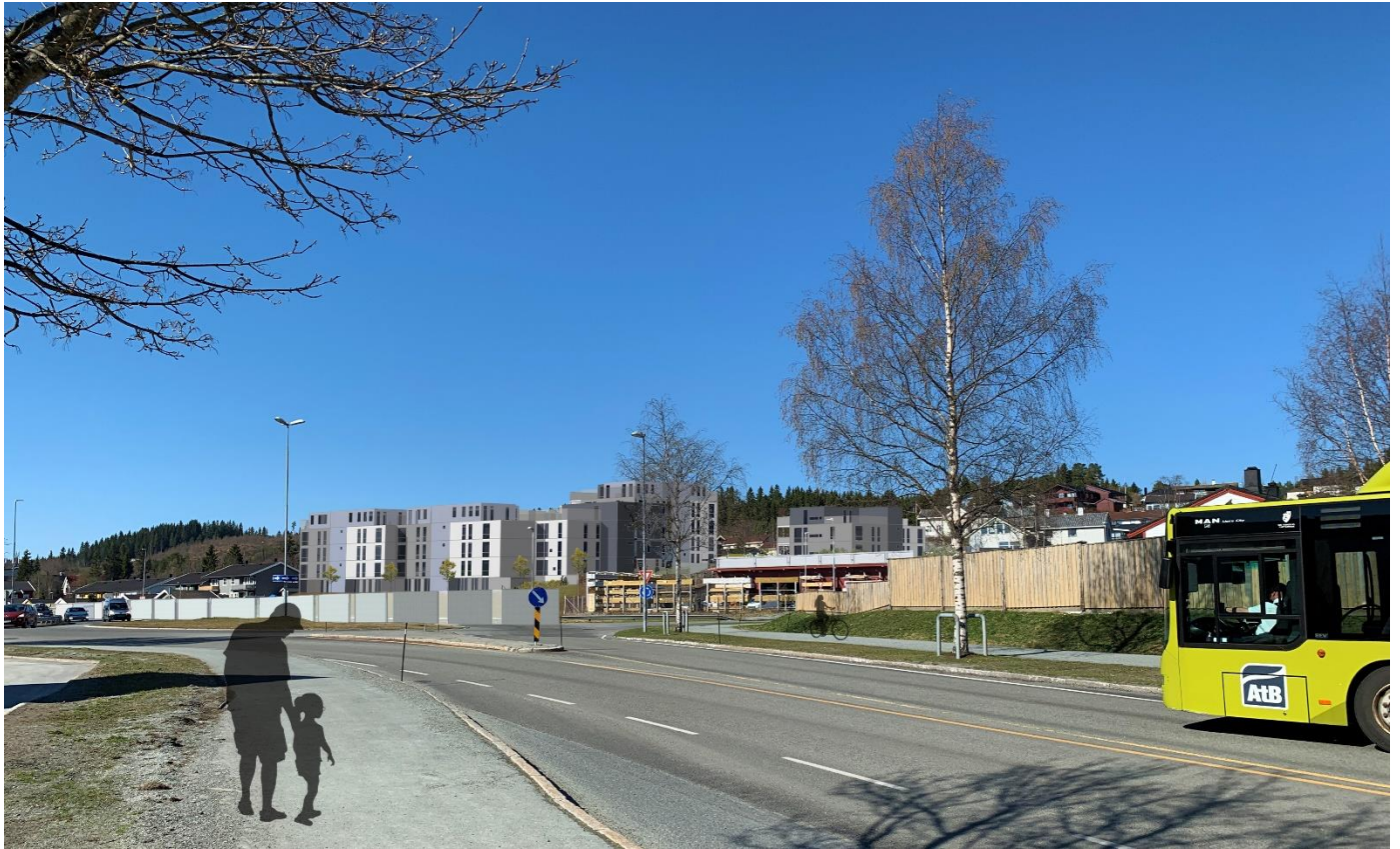
Standpunkt 2 med støyskjerm
