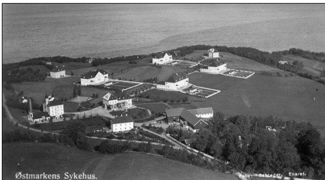
Figur 9: Flyfoto av Østmarka tatt på 1920-tallet. Vi ser gårdstunet og hagen ved Spannet til høyre i forgrunnen og den opprinnelige institusjonsbebyggelsen bakenfor. Parktrærne er ennå små/nyplantede. Sykehuset åpnet i 1919.
