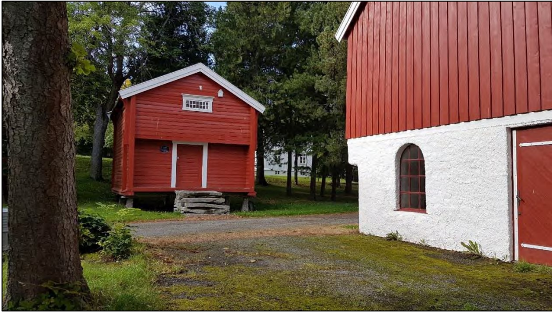
Figur 13: Bildet viser det ene av de to stabburene ved Spannet gård som nå er fredet
