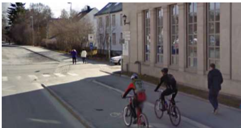
Figur 17: Hjørnet av Professor Brochs gate 6 hindrer sikt mot Professor Brochs gate for syklende fra nord. Kilde: Google Maps
