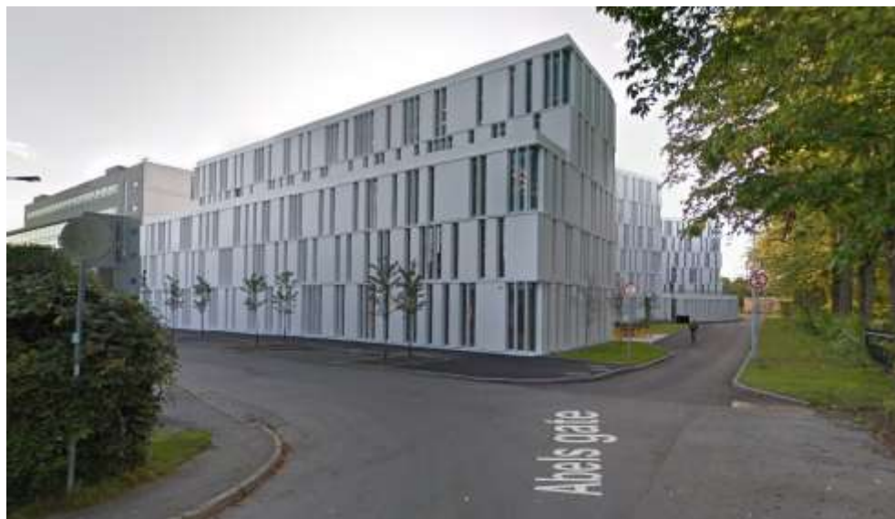
Figur 16: Nordvestre hjørne av Abels hus ved Abels gate. Gangforbindelse sørover mellom Abels hus og Tilfredshet kirkegård mot Professor Brochs gate. Kilde: Google Maps
