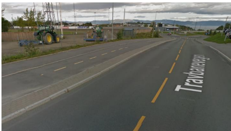
Figur 19: Sykkelveg med fortau nord i Tungavegen inn mot rundkjøring ved Travbanevegen (Kilde: Google Maps)
