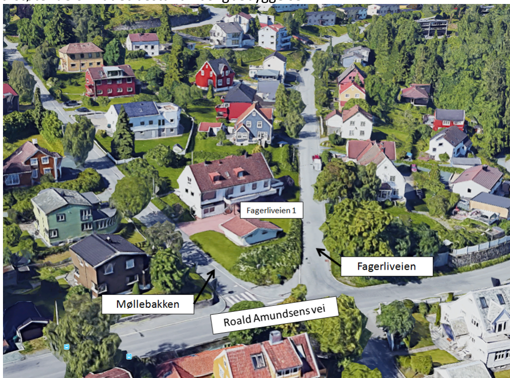
Fagerliveien 1 og nærområdet sett fra øst i Google maps 3D view
