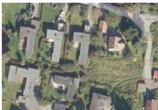
Vest for planområdet er det flere bygg i en etasje med flate tak
