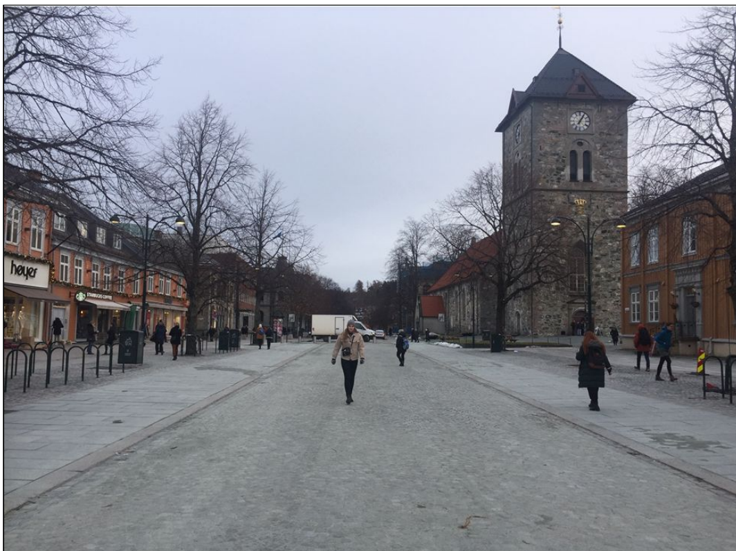
Østre del av Kongens gate, mellom Torvet og Nordre gate, der gatebruksplanen anbefaler å fjerne parkeringsplasser.
