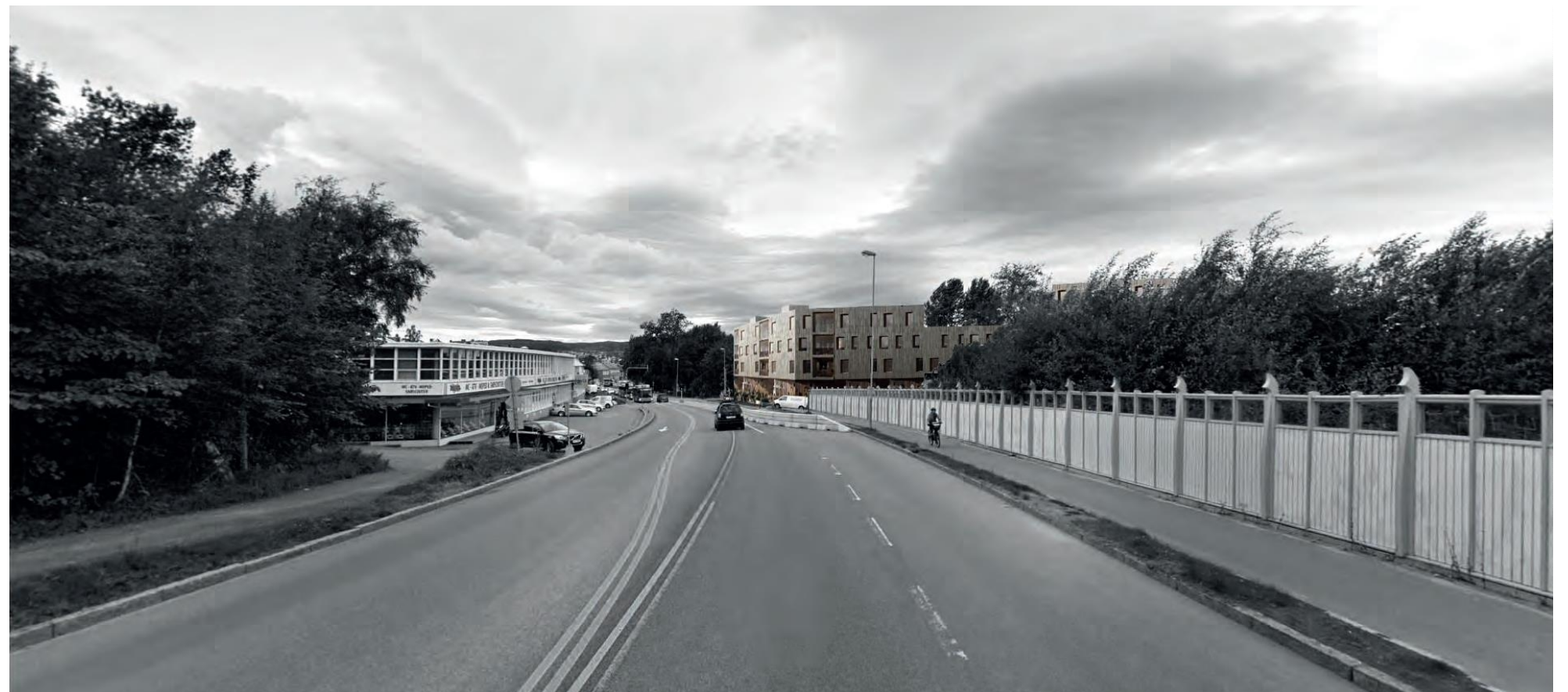
INNHERREDSVEIEN MOT VEST - ETTER
