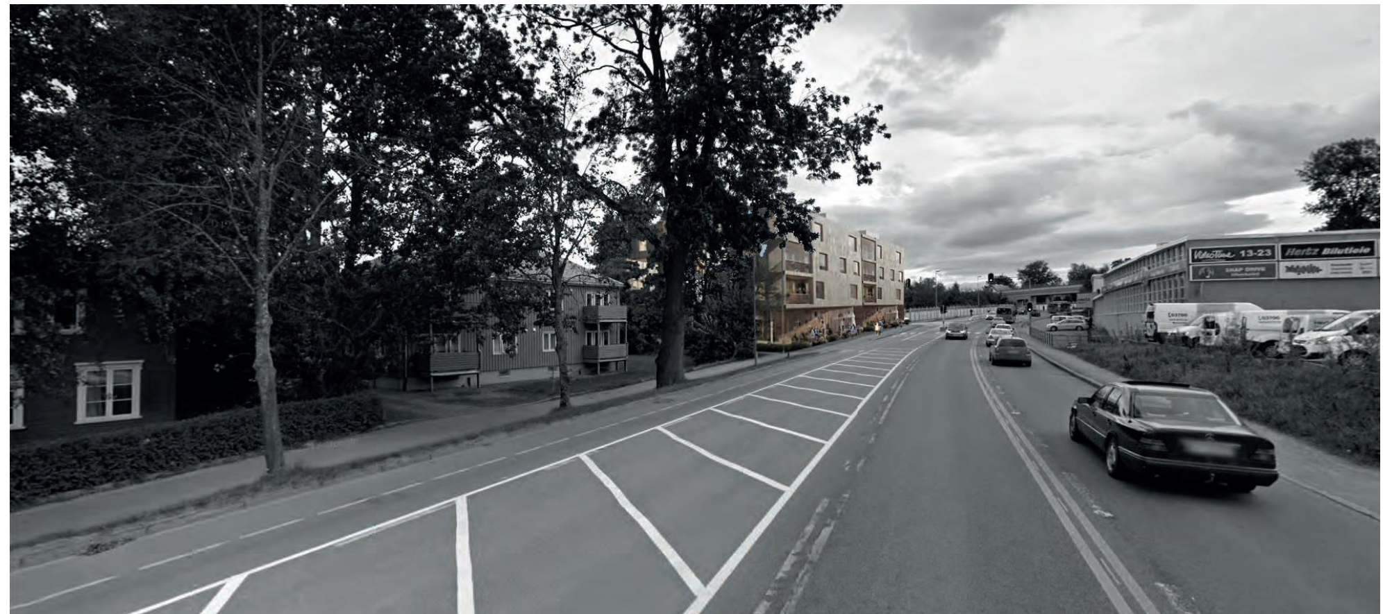
INNHERREDSVEIEN MOT ØST - ETTER
