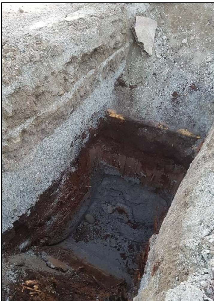
Figur 11: Prøvegrop PG7. Grus og pukk fra 0-1 m, og torv fra ca. 1-2 m. Leire påtruffet fra ca. 2 m under terreng.
