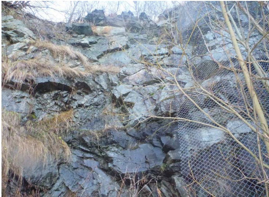
Foto 3: Skjæring bak dagens industribygg
