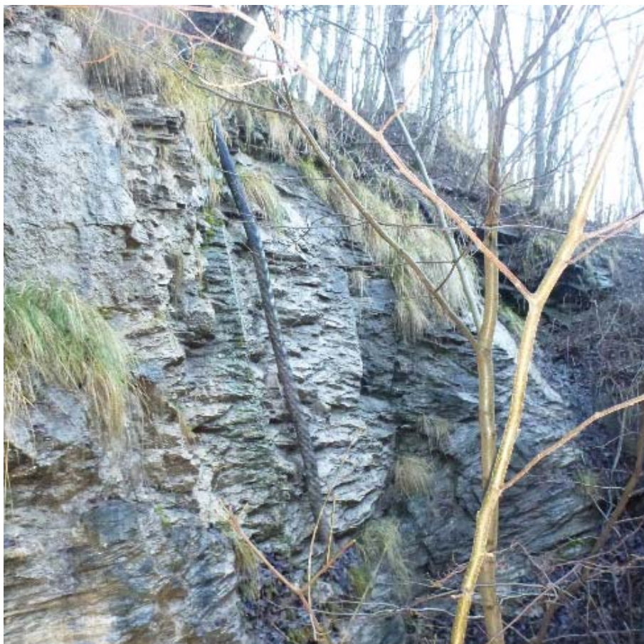
Foto 4: Drensør i skjæring bak industribygg
