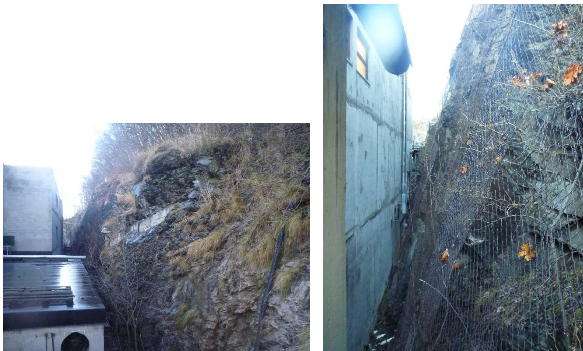
Foto 2 a, b: Skjæring bak dagens industribygg sikret med netting, festebolter og støttemurer.
