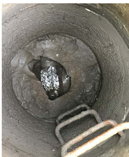
Venstre bilde: overvannkum med 600mm renne og 300mm utløp.
