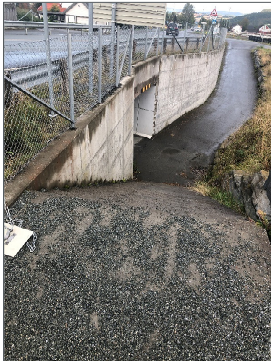
Figur 21: Trapp ned til kulvert i nordlig ende.
