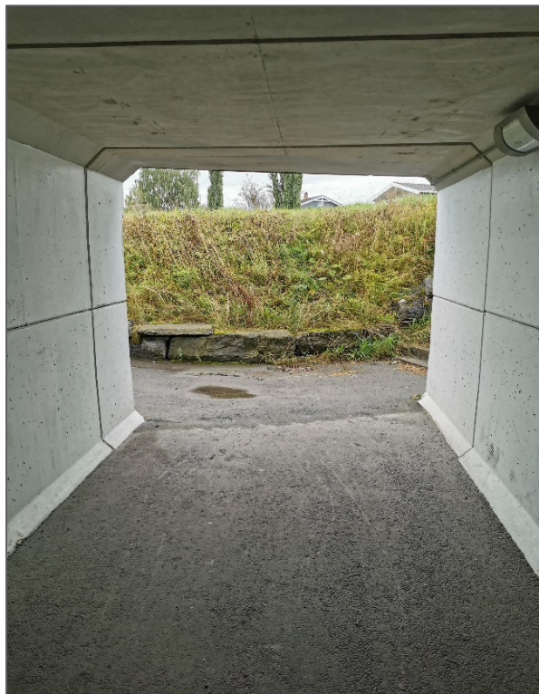
Figur 18: Inngang til kulvert fra nord.
