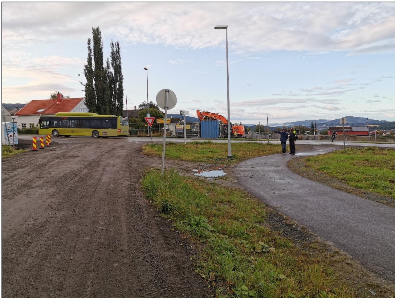
Figur 16: Sett fra Skjetleinvegen mot kryss til fv. 707
