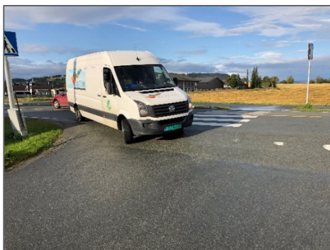
Figur 30: Bildet viser manglende plass utenfor kjørebane ved gangfelt nr. 1.
