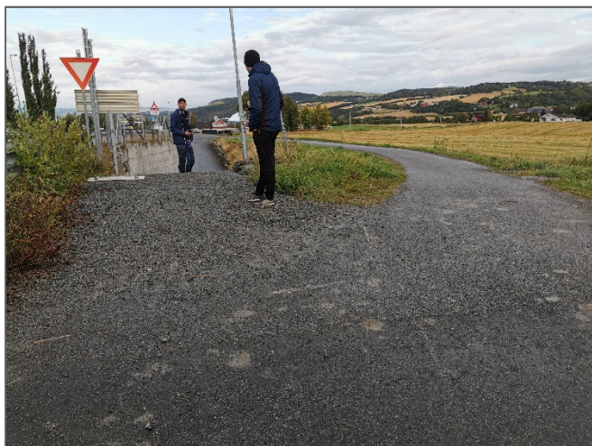
Figur 19: Ankomst mot kulvert fra Kammen.
